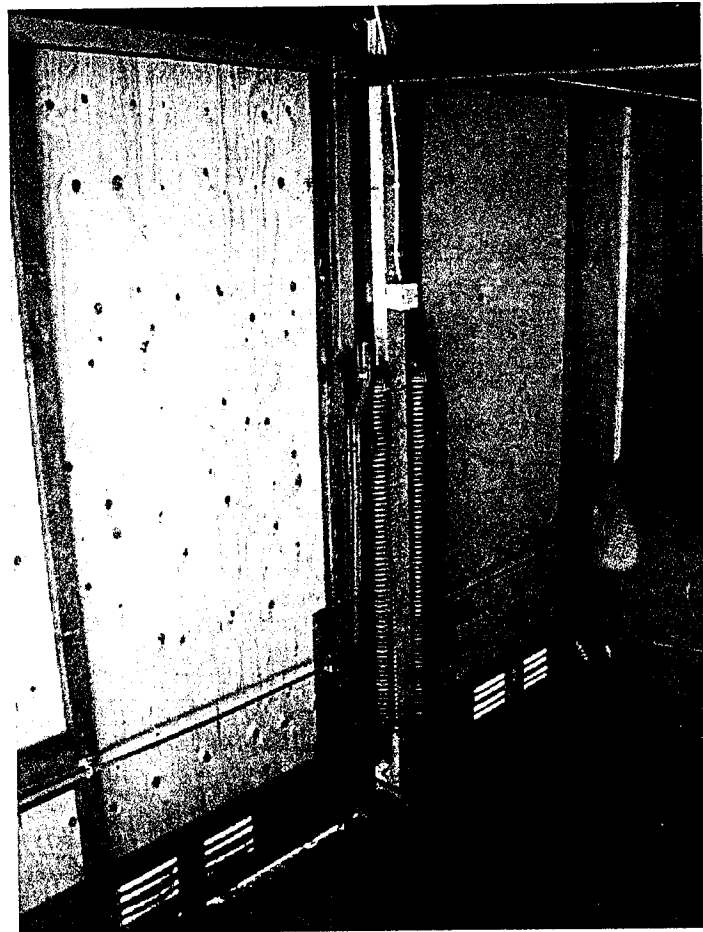
Provisorisk lagning av stolpen
