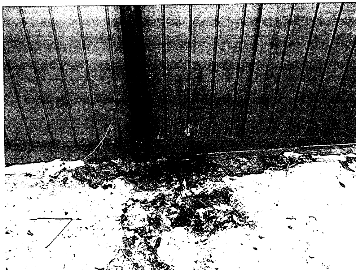
Olämpligt utsläpp från stuprören
