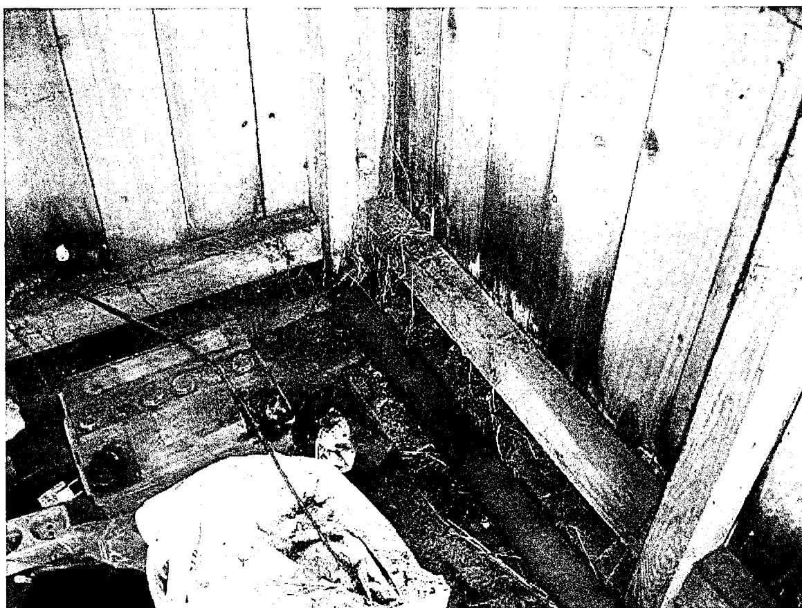
Rötskador i syllar, stolpar och panel
